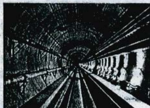
VUE D'UN TUNNEL FERROVIAIRE ACHÉVÉ
